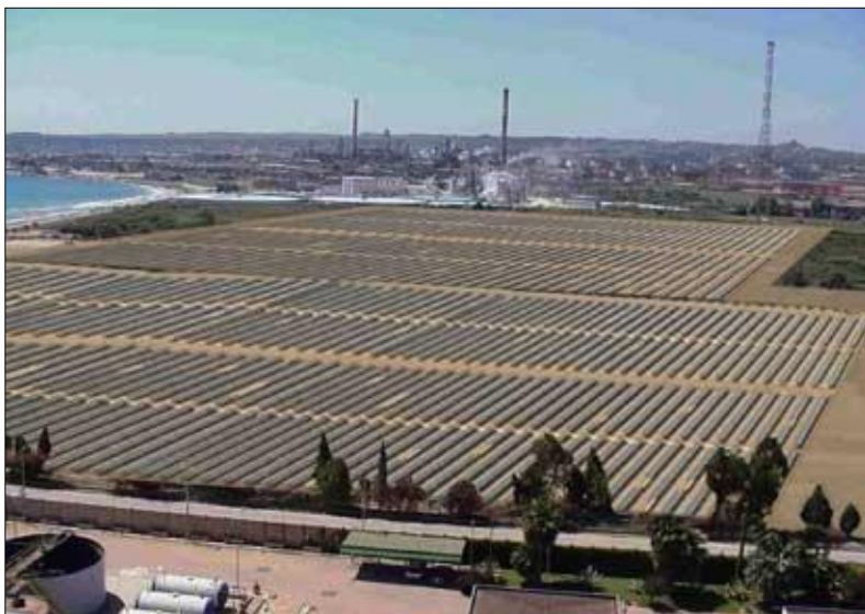
L'impianto pilota di solare termodinamico “Archimede” a Priolo
